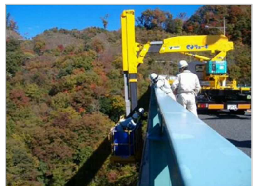
写真 1. 2 橋梁点検車による施設点検の実施状況
