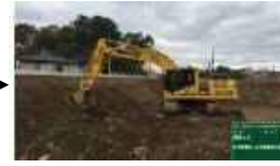
③ICT建設機械による施工
