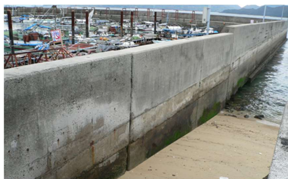
防波堤（忠海港二窓地区）
