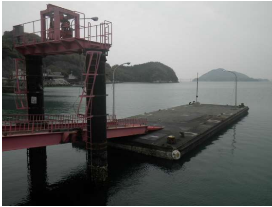
浮棧橋（倉橋漁港室尾地区）
