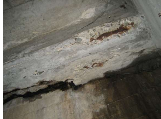
横桁の腐食
