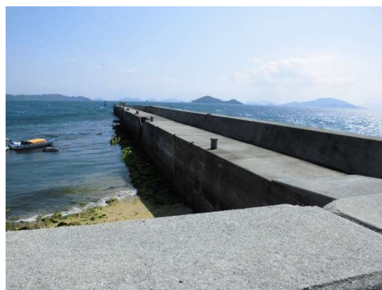
防波堤（倉橋漁港西宇土地区）
