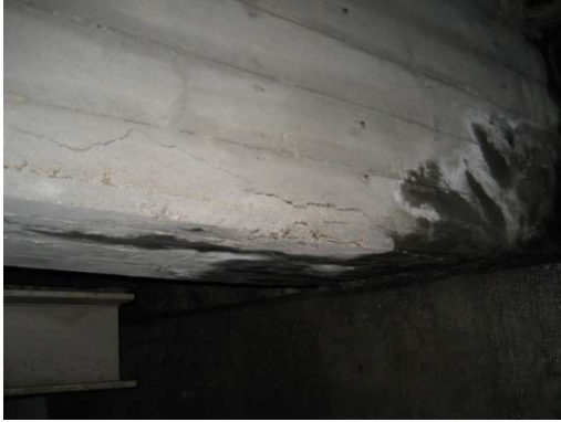
主桁の腐食
