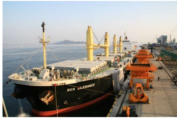
岸壁（大竹港東栄地区）
