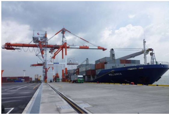
岸壁（福山港箕沖地区）
