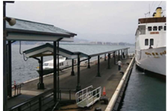
浮棧橋（厳島港胡町地区）
