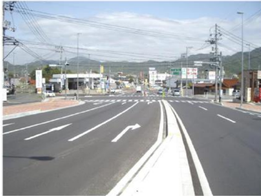
道路改良事業 矢野安浦線（安芸郡熊野町）
