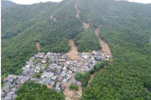
熊野町川角の被災状況
