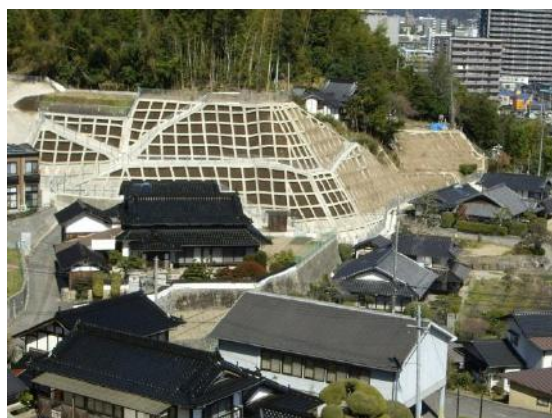
急傾斜地崩壊対策事業の施工例
