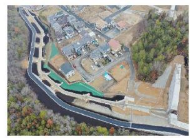
工事完了（令和4年3月8日）
