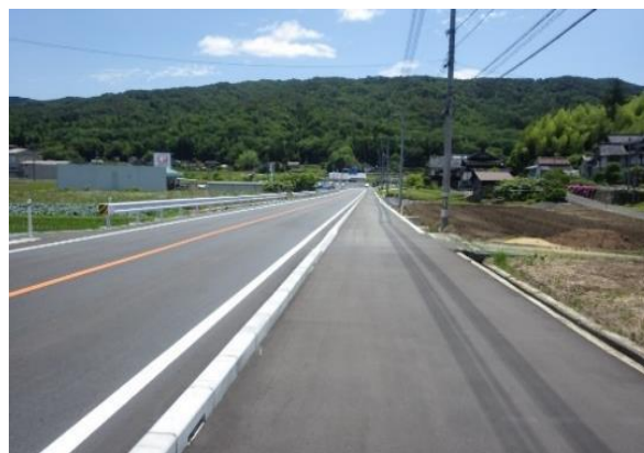
(主) 吉田豊栄線 交通安全施設等整備工事 (安芸高田市向原町戸島)
