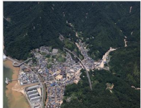
坂町小屋浦の被災状況
