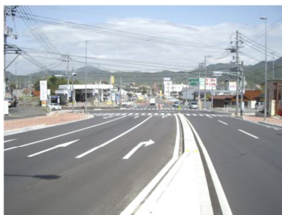
道路改良事業 矢野安浦線（安芸郡熊野町）
