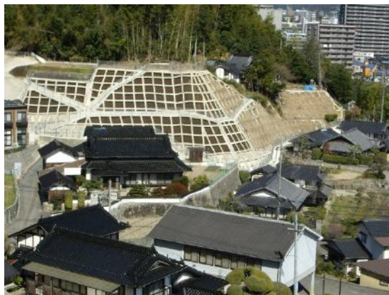
急傾斜地崩壊対策事業の施工例
