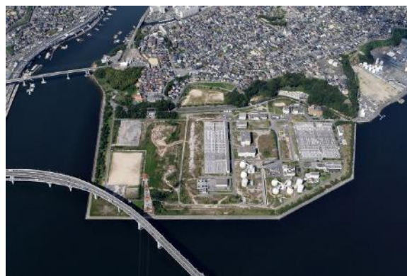
太田川流域下水道 東部浄化センター (広島市南区向洋沖町)
