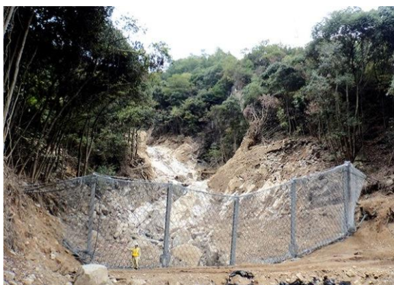
応急対策状況
