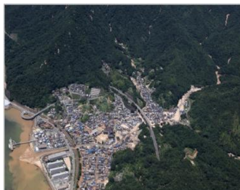
坂町小屋浦の被災状況
