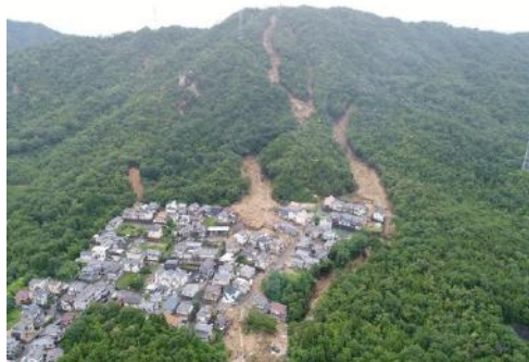
熊野町川角の被災状況
