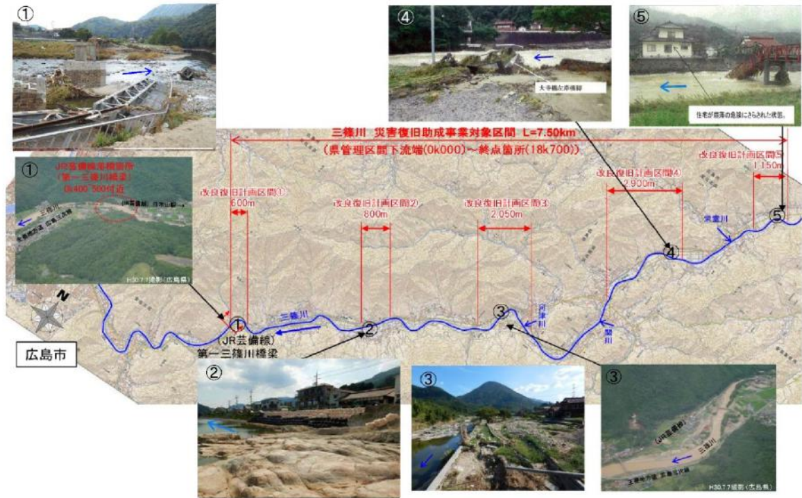
被災状況と復旧区間
