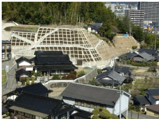
急傾斜地崩壊対策事業の施工例
