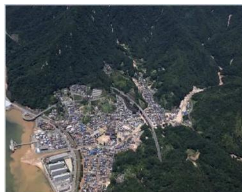
坂町小屋浦の被災状況
