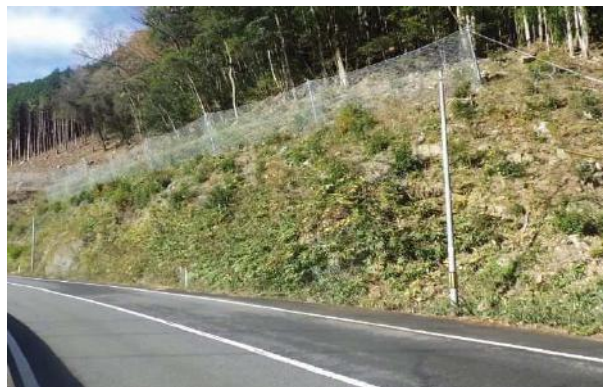
(一) 北船木線 道路災害防除工事 (安芸高田市高宮町船木)
