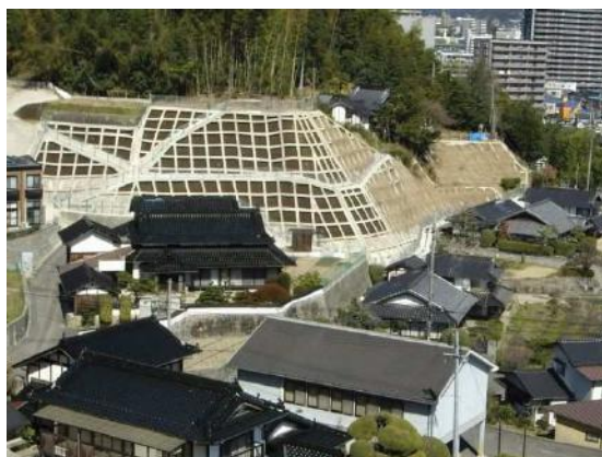
急傾斜地崩壊対策事業の施工例
