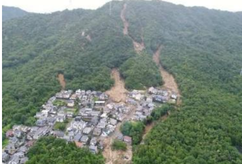
熊野町川角の被災状況
