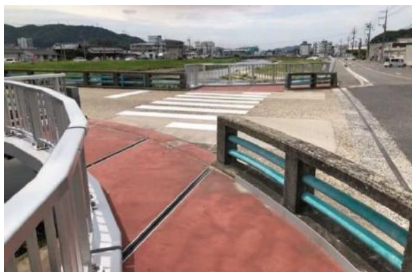
(主) 東海田広島線 交通安全施設等整備工事 (安芸郡海田町畝)
