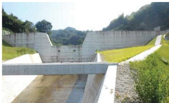
砂防事業の施工例
