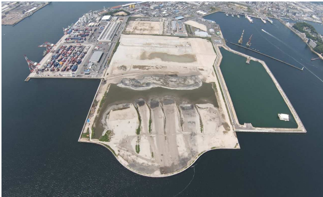
出島地区港湾整備事業〔航空写真(令和3年6月撮影)〕
