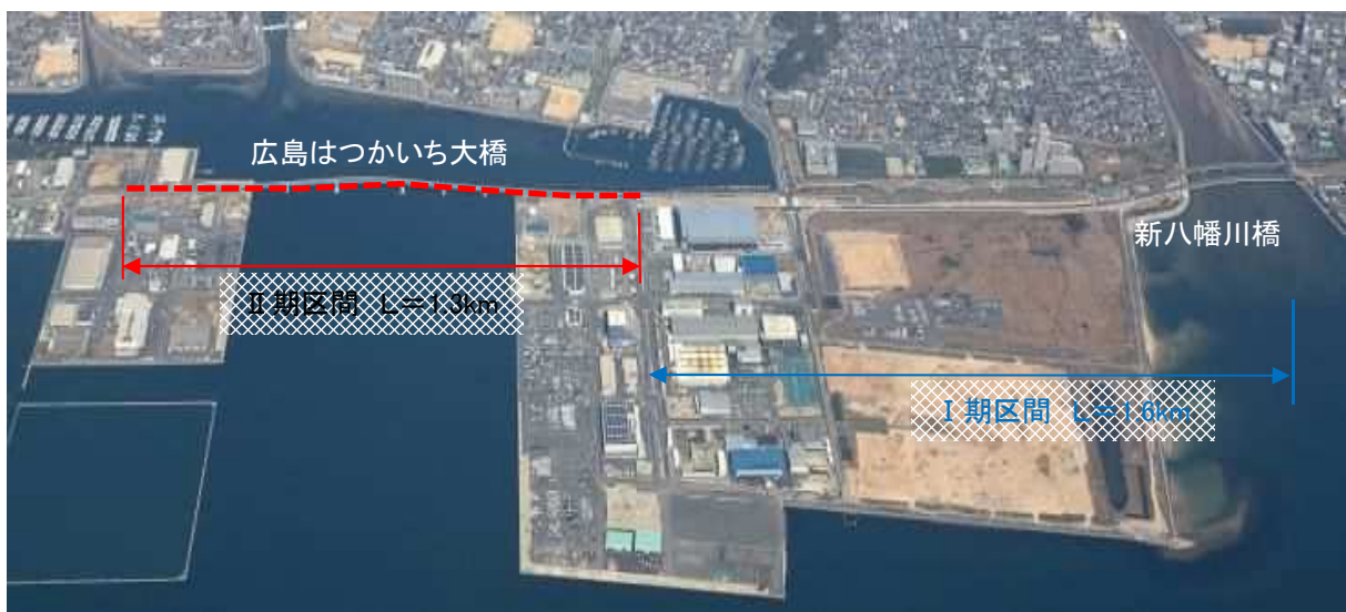
臨港道路廿日市草津線整備事業〔航空写真(平成29年4月撮影)〕
