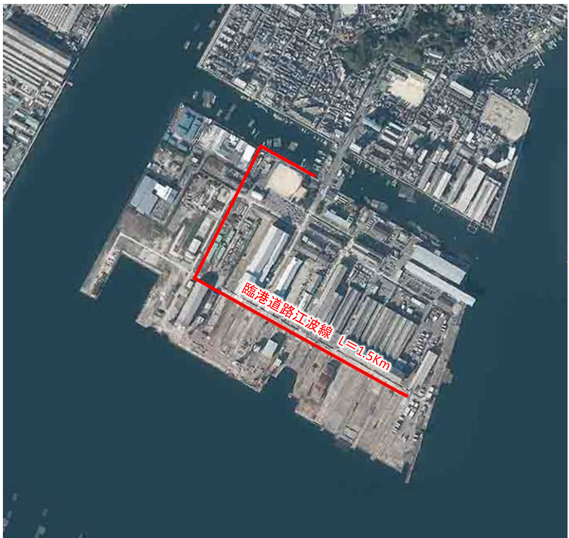
臨港道路江波線整備事業〔航空写真(平成29年12月)〕
