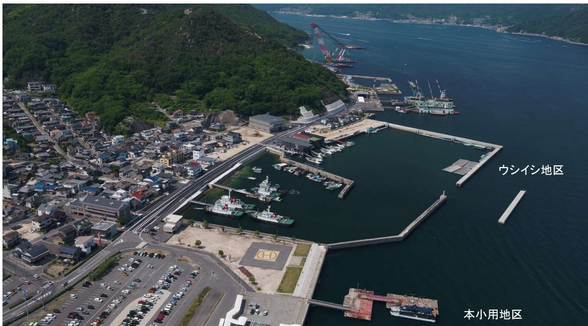
[小用港 本小用地区 ウシイシ地区 令和4年6月撮影]
