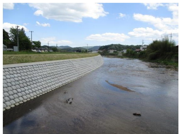
広域基幹河川改修事業（志路原川・春木工区）
