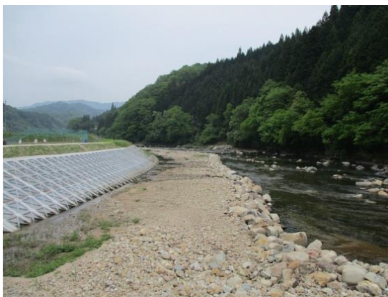
広域基幹河川改修事業（江の川・川戸工区）
