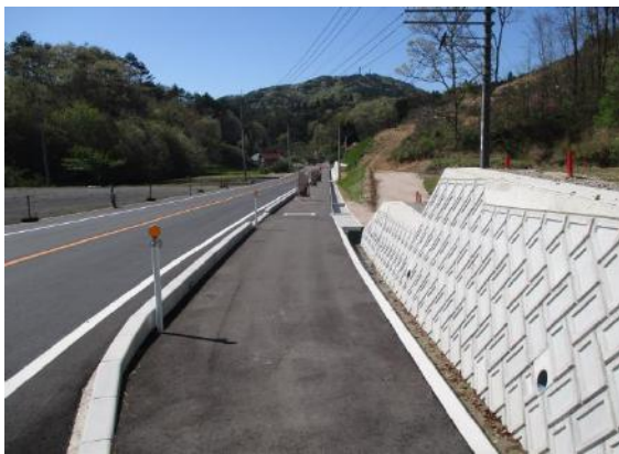
(国) 186号 歩道の整備 北広島町(旧芸北町)
