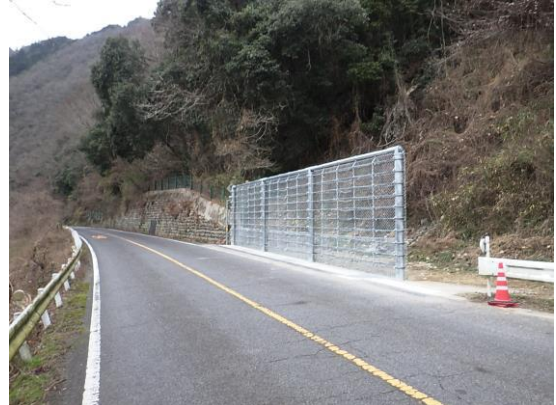
国道191号 高強度落石防止柵 安芸太田町穴（旧加計町）
