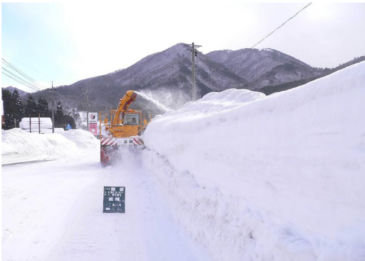
除雪作業状況
