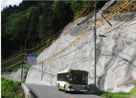
国道191号 落石防止網・モルタル吹付 安芸太田町川手（旧戸河内町）
