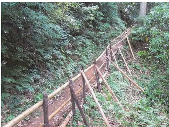
団体が設置した遊歩道の防護柵
