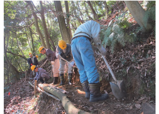
林内散策道の補修
