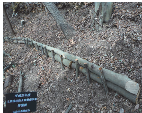
土砂流亡を防ぐための丸太柵の設置
