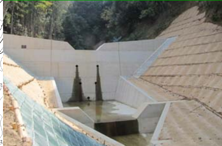
【治山】①-35 遠筒瀬1地区[溪間工](大林町)
