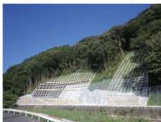
法面災害防除工事例 (法枠工事)
