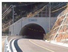
道路改良工事例 (バイパス整備)
