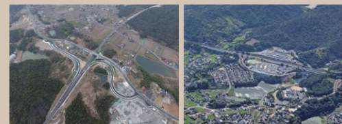
東広島呉道路 大多田 IC (東広島市黒瀬町) 【H29 完成】
