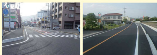
国道2号 西御所～新浜工区 (尾道市西御所町) 【R2 完成】
