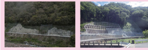
【法面対策】 国道191号 坪野工区 (山県郡安芸太田町) 【R2 完成】
