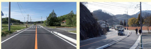
(主) 世羅甲田線 青水工区 (世羅郡世羅町) 【R1 完成】
