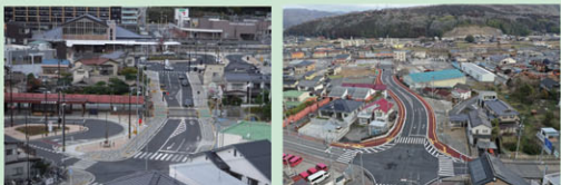
(都) 廿日市駅通線 (廿日市市駅前) 【H30 完成】
