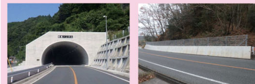
【バイパス整備】 国道186号 御園バイパス (大竹市防鹿) 【H29 部分完成】
