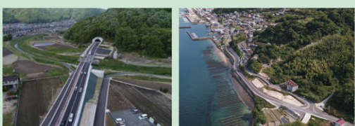
国道313号 神辺バイパス (福山市神辺町) 【H29 完成】
