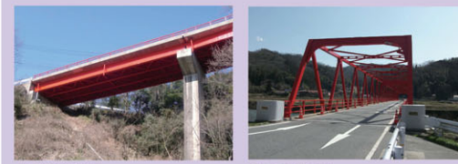
【橋梁補修】 国道182号 三曲橋 (福山市加茂町) 【H29 完了】
