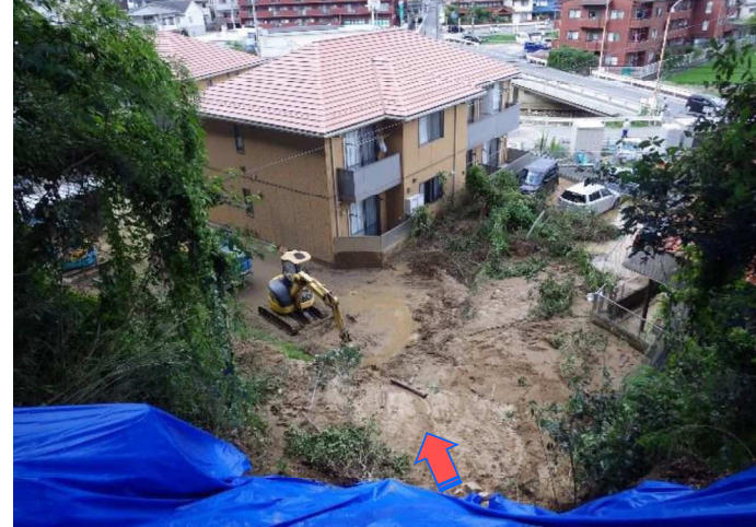
斜面崩壊状況
