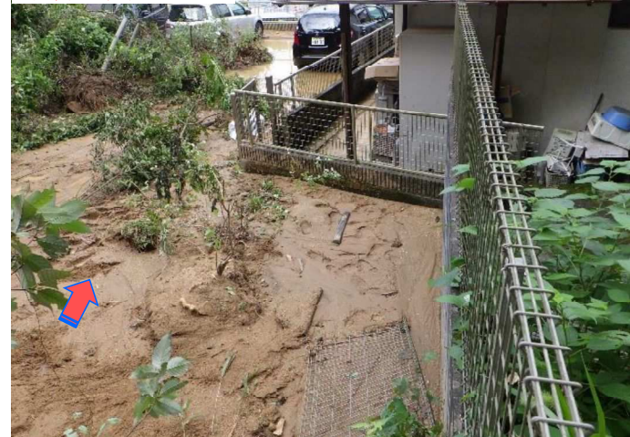
崩壊土砂流出状況
