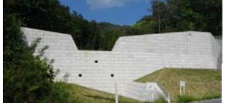
砂防堰堤 7 溪流完成
