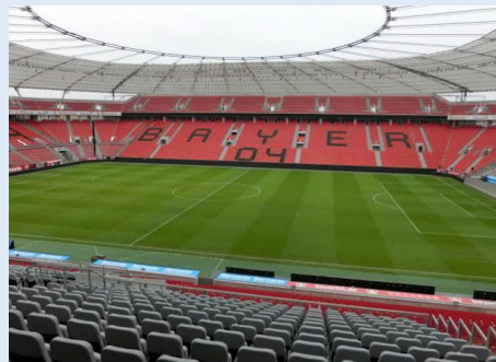
ピッチ全景 屋根が半透明のためピッチはとても明るく、芝にも良い環境。
