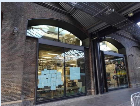
レンガ倉庫のスーパー 古いレンガ倉庫を改修して、スーパーとして活用。
