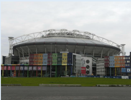
スタジアム外観 カラフルな各種複合施設がスタジアムに併設。
