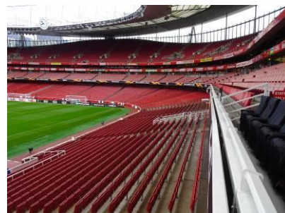
緩勾配のスタンド (イングランド)
