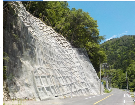
災害復旧完了
