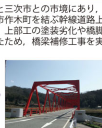
補修後 (H30年)
