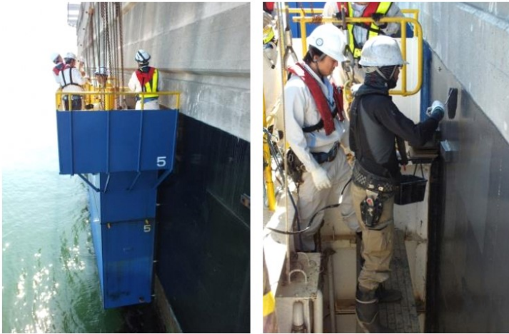
ケーソンライニング施工状況 (北備讃瀬戸大橋)
