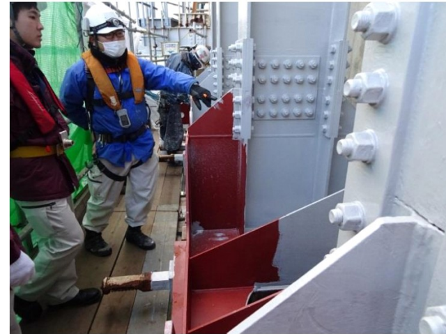
主塔基礎補修塗装施工状況(明石海峡大橋)
