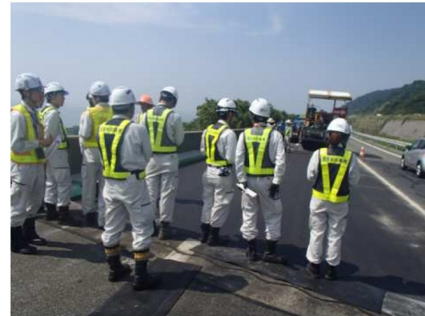
床版防水施工状況(神戸管理C管内)
