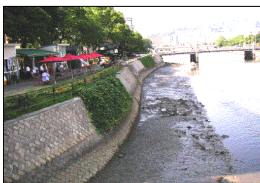
写真-5.7.1 対象干潟の外観 2) (施工前2009年12月)
