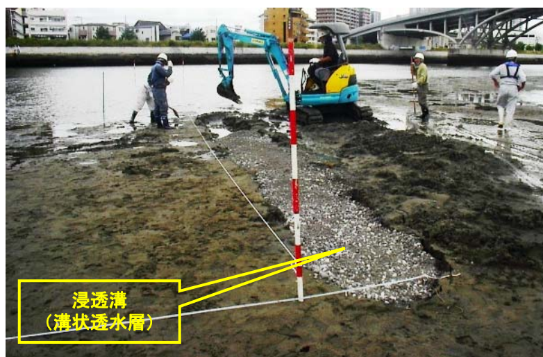
写真-4.1.4 浸透溝（溝状透水層）の施工状況
