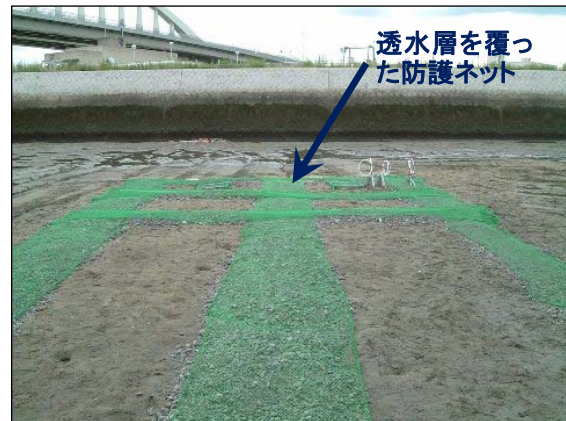
(完成写真、計測機器の設置状況)
