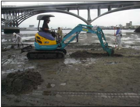
(バックホウによる溝の掘削)
