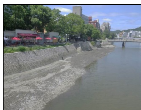
写真-5.7.2 大規模試験区構築 2) (施工後2013年5月)
