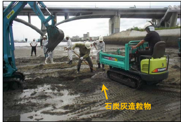
(石炭灰造粒物の溝内投入・敷き均し)
