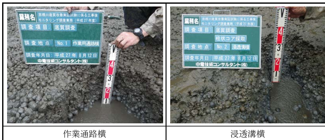
写真-6.4.4 底質調査状況（作業通路、浸透溝）
