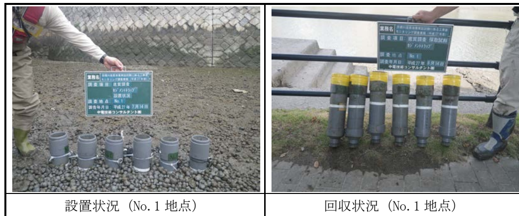
写真-6.4.5 セジメントトラップの設置状況
