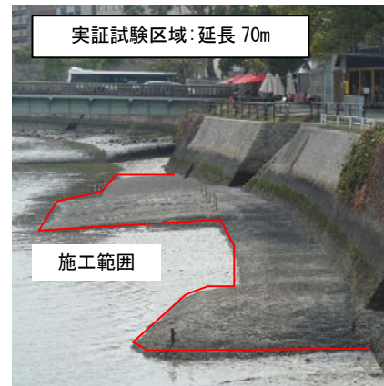
(施工完了時 2011 年 3 月)
