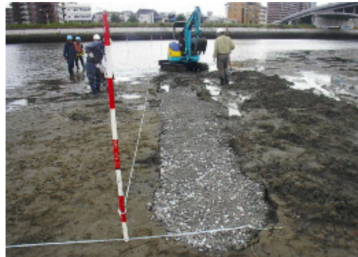
②浸透溝（京橋川宇品橋付近）
