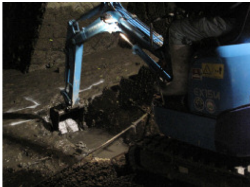
③浸透溝（京橋川オープンカフェ前）
