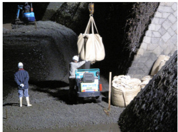
(b) 完成した作業道（奥は作業拠点）
