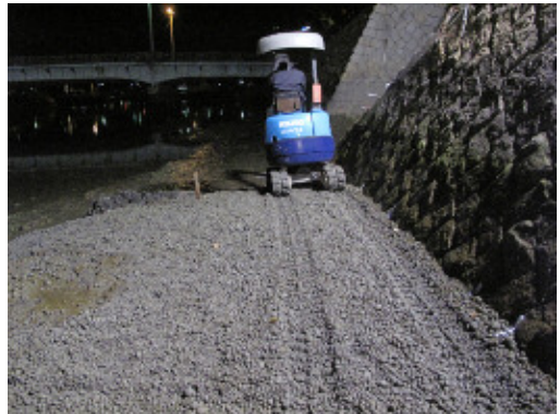
④作業道（京橋川オープンカフェ前）
