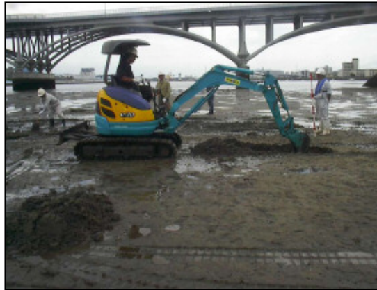
図- 5.5 安定（歩行可能）地盤上での掘削作業
