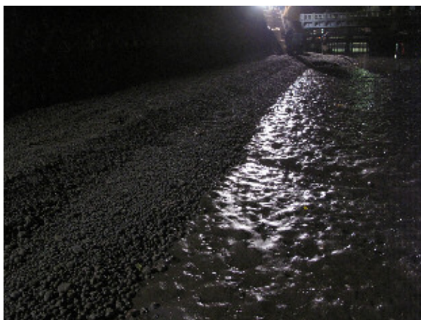
(c) 陸上拠点からクレーンによって石炭灰造粒物を干潟上に降ろす状況、奥はバックホウによるならし作業
