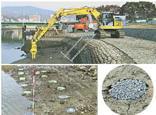
①浸透柱（旧太田川空鞆橋付近）
