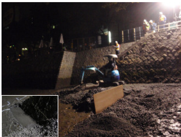
(a) 浸透溝を掘削しつつ作業道を構築
