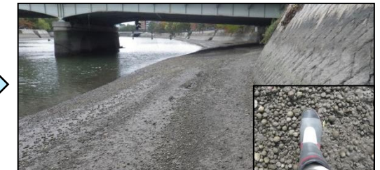
施工後約 42 箇月 (H28.11月)
