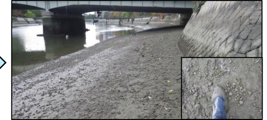
施工後約 30 箇月 (H27.11月)
