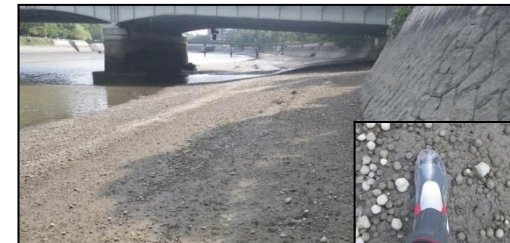
施工後約 39 箇月 (H28.8月)
