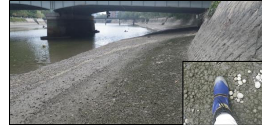
施工後約 27 箇月 (H27.8月)
