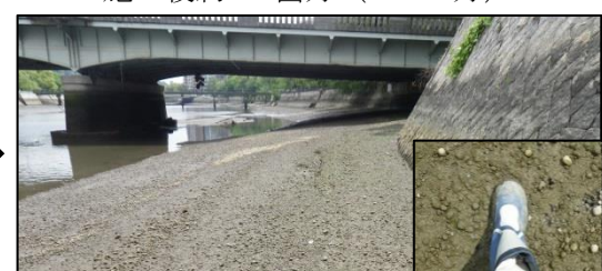
施工後約 24 箇月 (H27.5月)
