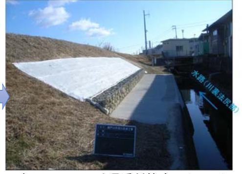
ドレーン工による浸透対策完了(H30.3)
