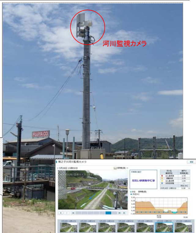
図. 河川映像の公開(河川防災情報システムより)
