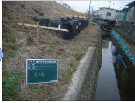
浸透対策前(土嚢による応急復旧)
