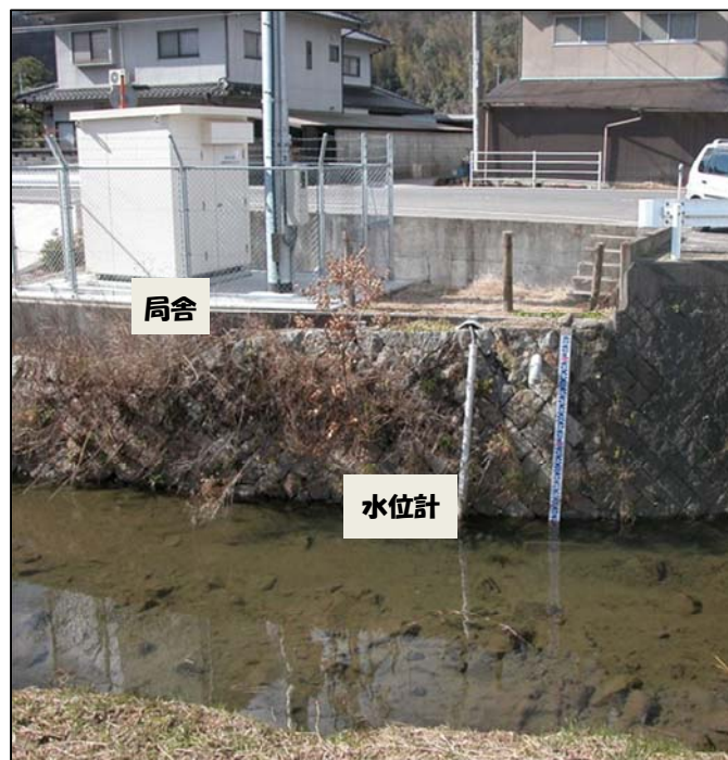
図-7 水位計設置事例（芦田川水系服部川）
