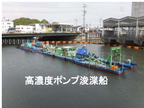
施工状況(河床浚渫工事)
