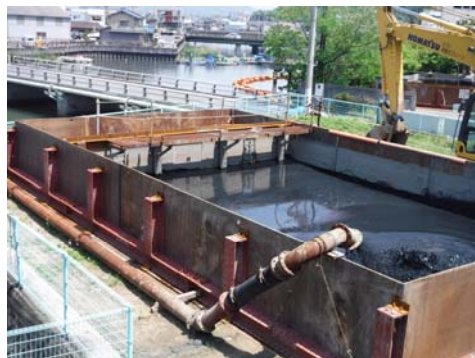
施工状況(河床浚渫工事)
