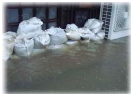
写真:「土のうによる水防対策」(江戸川区土木部)から引用
