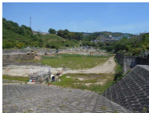
施工中(堆積土除去)
