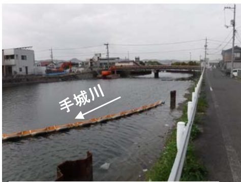
施工状況(地盤改良工事完了)
