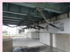
橋梁耐震工事例(落橋防止)
