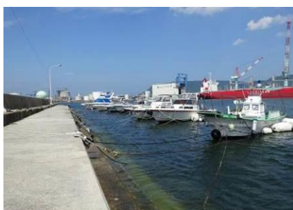
泊地C。条件があまりよくないが、現に船舶が係留している場所。（写真の場所は、航路に近く、やや波高が高い。）
