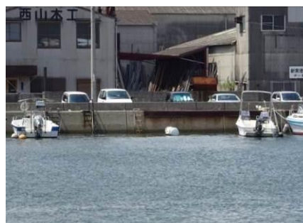
泊地B。護岸等外郭施設前面
