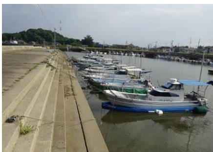
県整備の簡易な係留保管施設。泊地内の岸壁を利用し、係船環を設置している。
