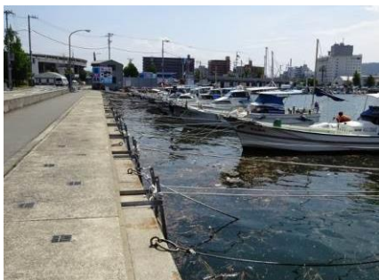
泊地A。係留施設（岸壁）前面。県が岸壁を改修し、係船環と梯子を設置している。
