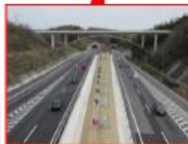
松永道路4車線化完成 (H29年3月)
