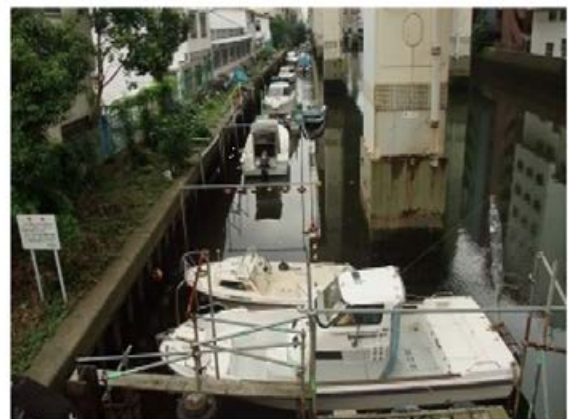
狭隘な河川内に係留され、流下阻害
