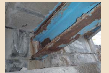
(国) 2号(尾道市新浜) 鋼橋 橋長18.0m 1967年供用
