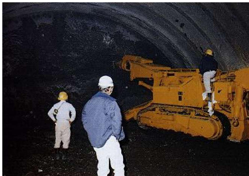
機械掘削状況
