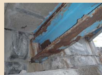
(国) 2号 (尾道市新浜) 鋼橋 橋長18.0m 1967年供用
