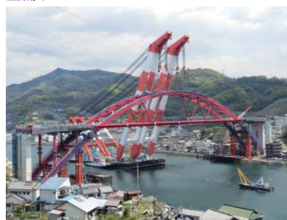
(仮称) 第2音戸大橋
