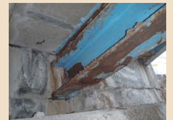
(国) 2号（尾道市新浜）鋼橋 橋長18.0m 1967年供用
