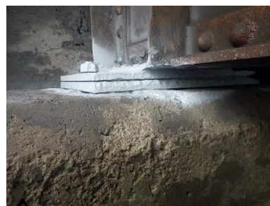
金属溶射完了
