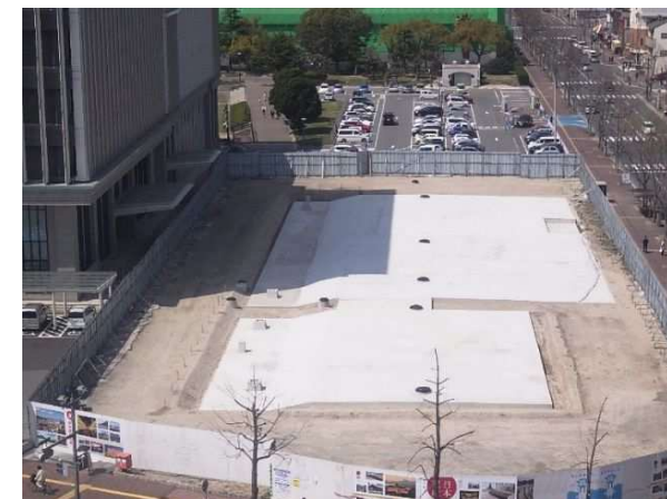
施設全景(工事中)
