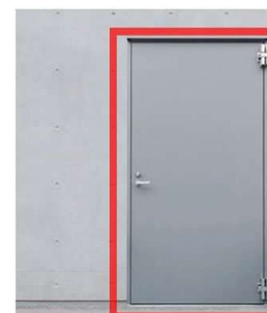
防水扉の設置
