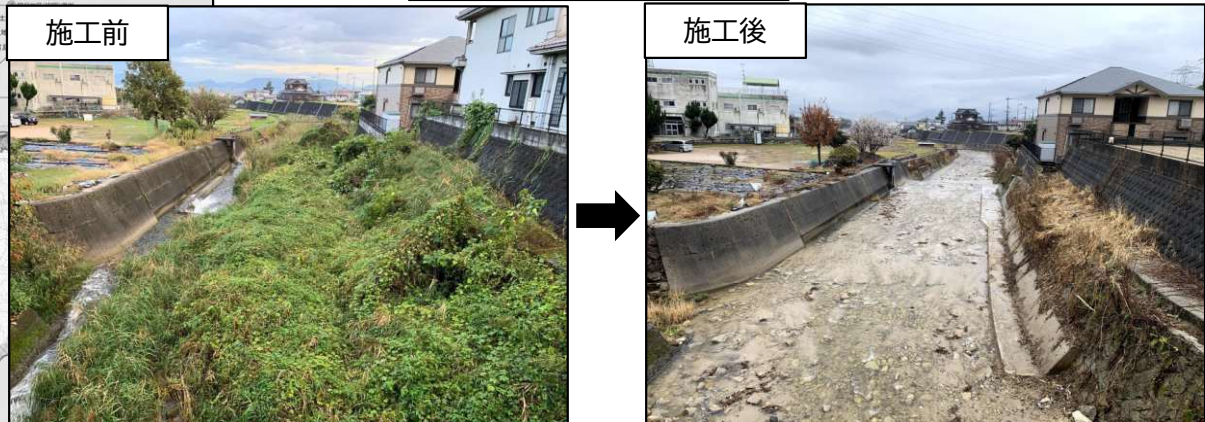
河川浚渫工事(可愛川)
