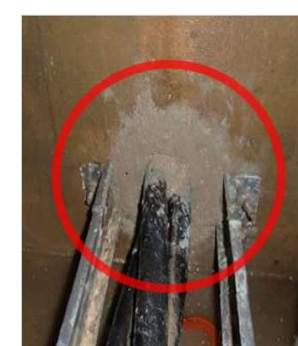
ケーブル貫通部の閉塞
