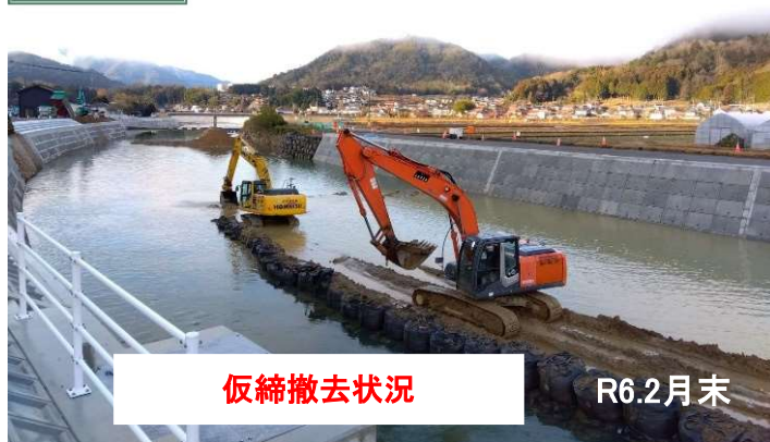
写真② 仮締撤去状況
