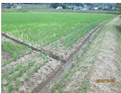
②ほ場内排水溝の設置
