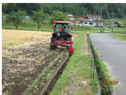
①明渠の設置
