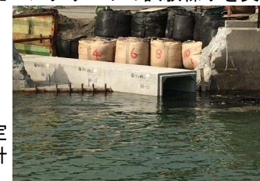
ボックスカルバート施工例
