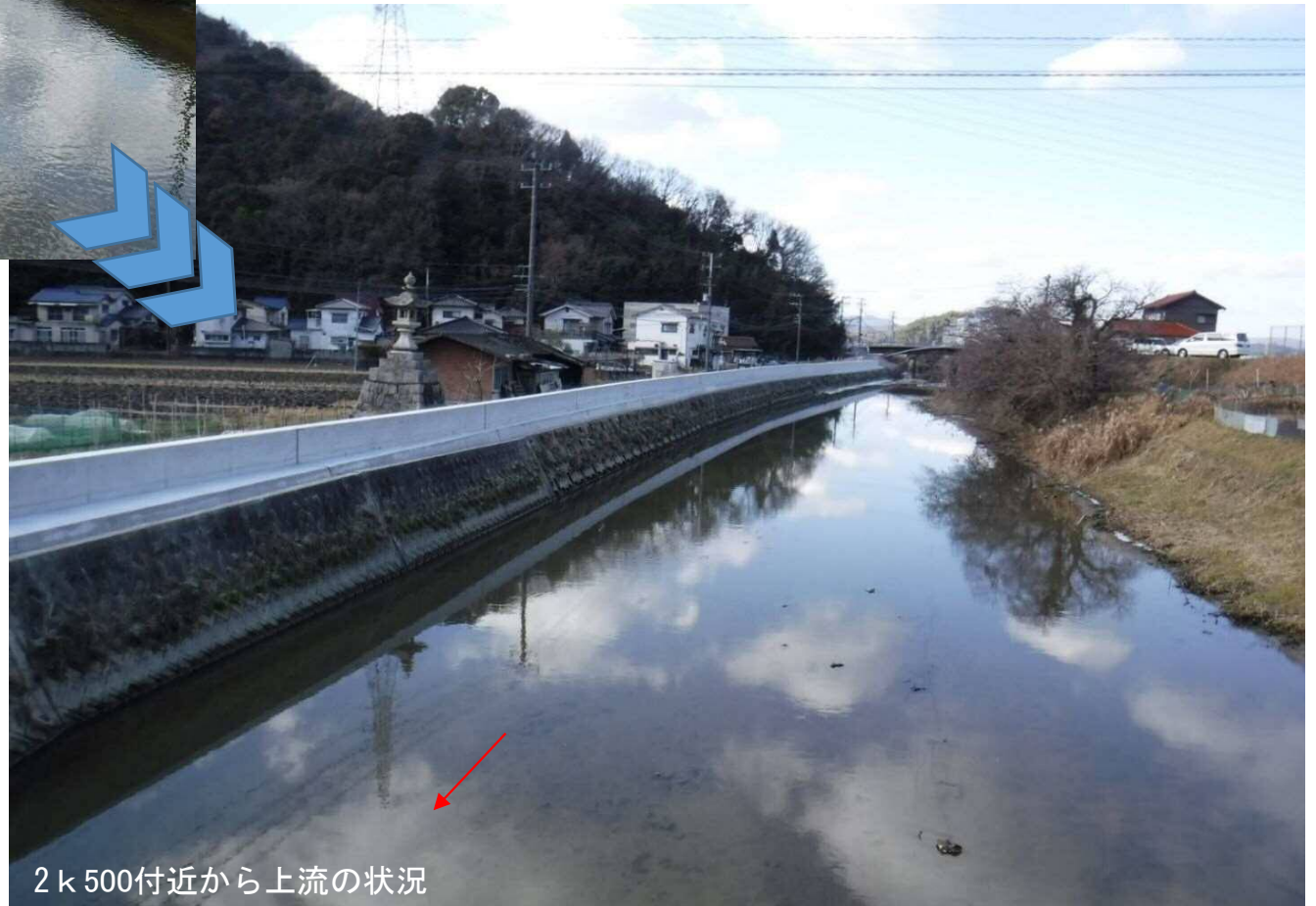
擁壁工事完成 (令和3年2月撮影)
