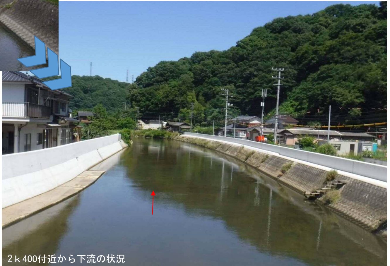
擁壁工事完成 (令和4年6月撮影)
