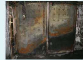
1階階段室の防火戸
