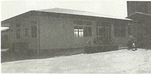
完成した業務課棟
