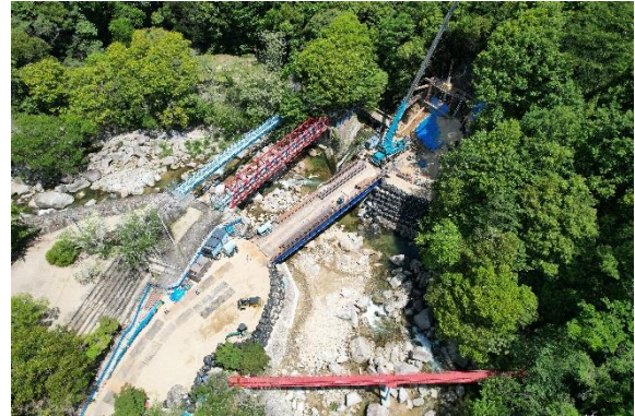
上二河地区の工事状況
