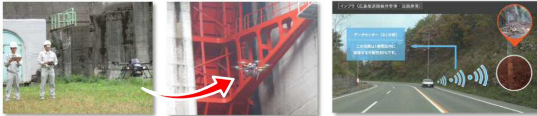
【ドローンを活用した施設点検】
