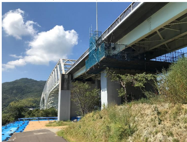
耐震補強施工状況（P 1 橋脚）
