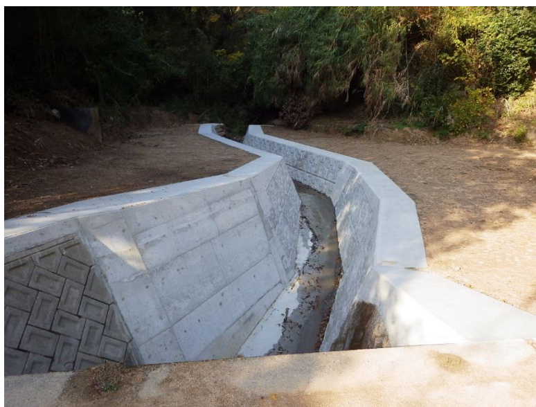
(砂) 海越川 砂防災害復旧工事
