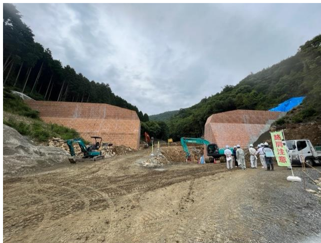
通常砂防事業 砂防指定地内河川 光明寺川
