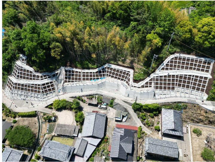
急傾斜地崩壊対策事業 畑三丁目
