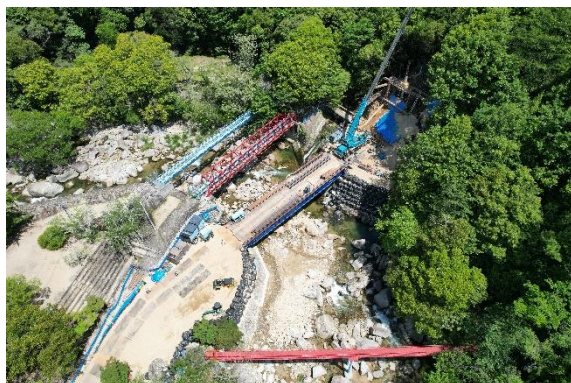
【(主) 呉平谷線 道路改良工事】
