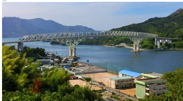
一般国道487号 早瀬大橋
