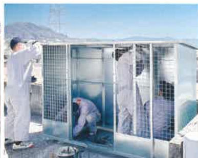
ゴミステーション設置
