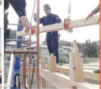
模擬家屋棟上げ実習
