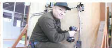
配線工事実習
