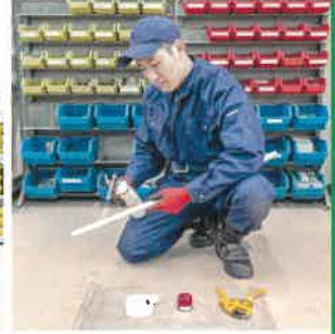
合成樹脂管工事
