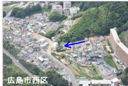
令和3年8月豪雨災害の被災状況
