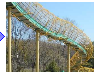
○遊具のハザード除去(例:すべり台からの落下防止対策)
