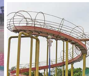
○遊具のハザード除去(例:すべり台からの落下防止対策)
