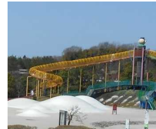
○遊具のハザード除去(例:すべり台からの落下防止対策)
