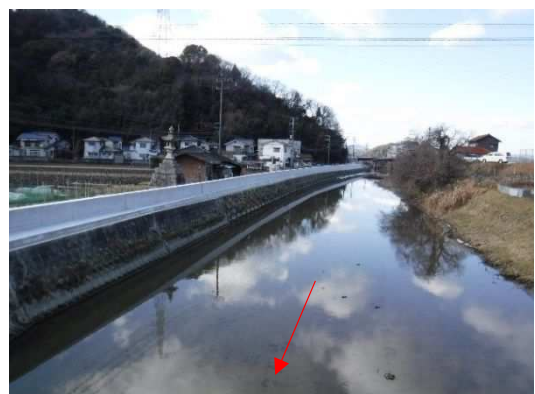
護岸の嵩上げ（天井川：三原市明神）
