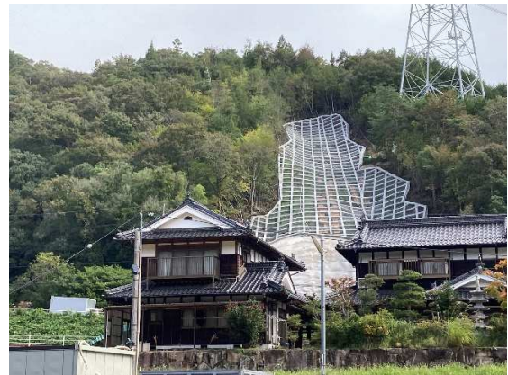
山腹工(東広島市)
