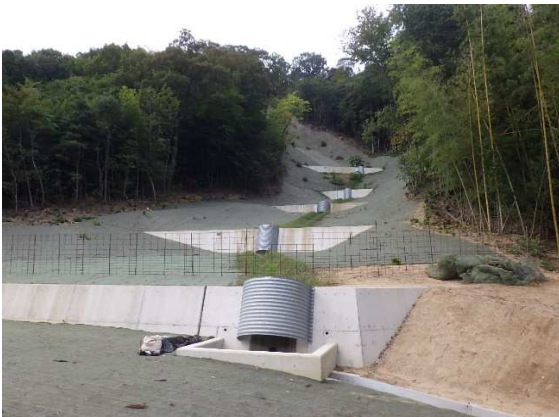
山腹工(東広島市)
