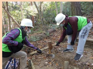
歩道整備(木製階段作り)
