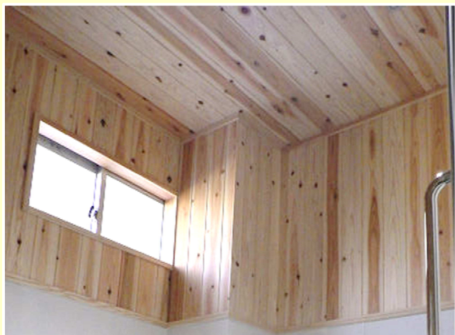
細部の施工状況(緑の相談所)
