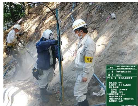
削孔と補強材挿入
