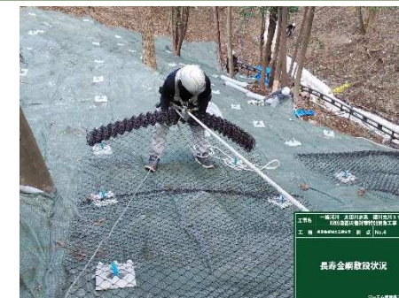
金網敷設中 1名の人力で敷設可能
