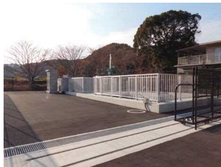
令和4年6月完成
