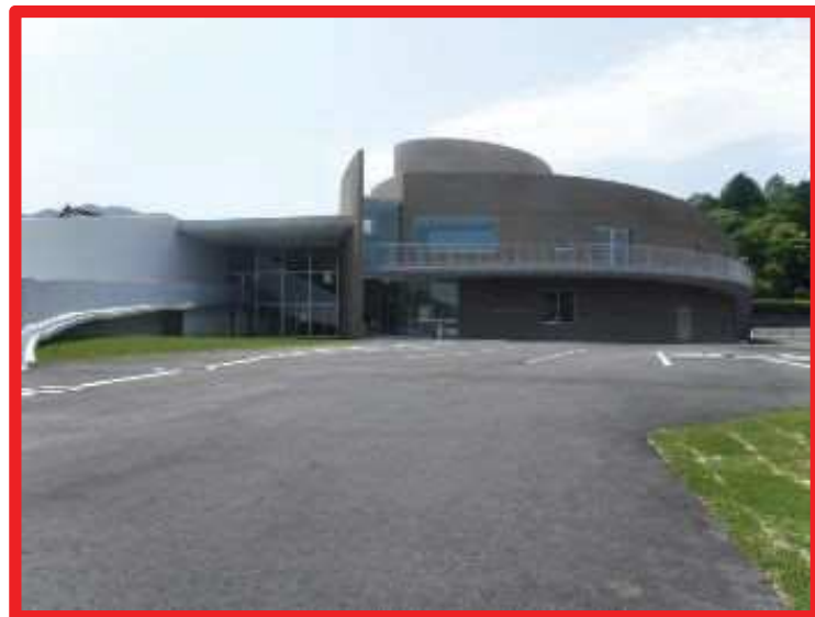
熊野東防災交流センター
