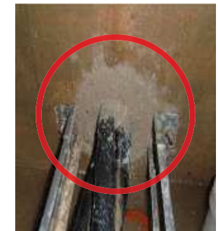
ケーブル貫通部の閉塞
