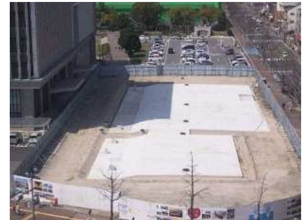
施設全景(工事中)
